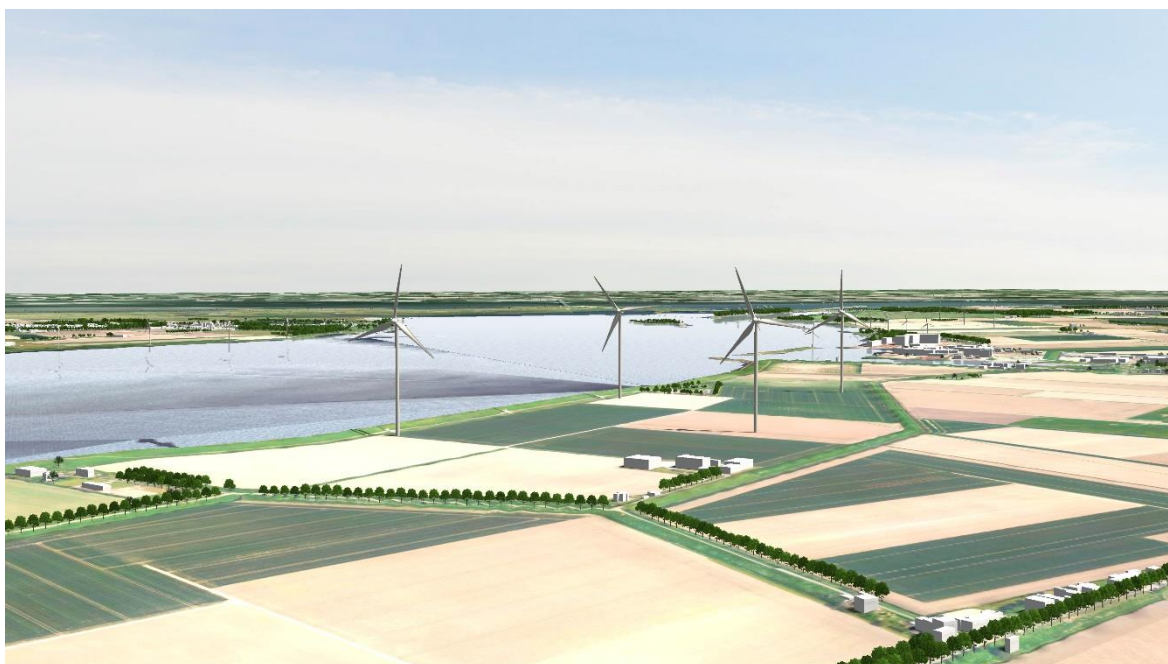
Figuur 2.5 Impressie van de clusteropstelling met een rotordiameter 140 m.( bron ROM 3D)
