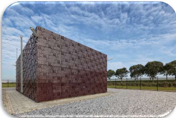
Gasontvangstation bedekt met biocomposiet gevel
