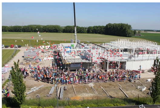
Brede School plaatsen gevelstenen
