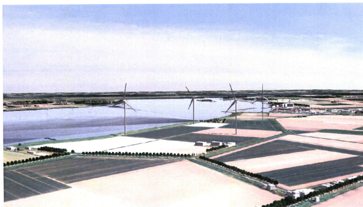
Impressie van de clusteropstelling met een rotordiameter 140 meter. Deze impressie sluit aan bij de opstellingsvariant met een tiphoogte van ongeveer 210 meter. (bron: ROM 3D)
