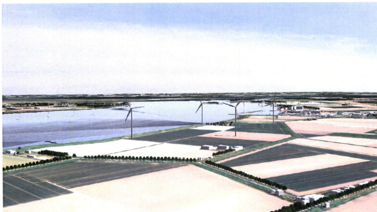
Impressie van de clusteropstelling met een rotordiameter 120 meter. Deze impressie sluit aan bij de opstellingsvariant met een tiphoogte van ongeveer 180 meter. (bron: ROM 3D)
